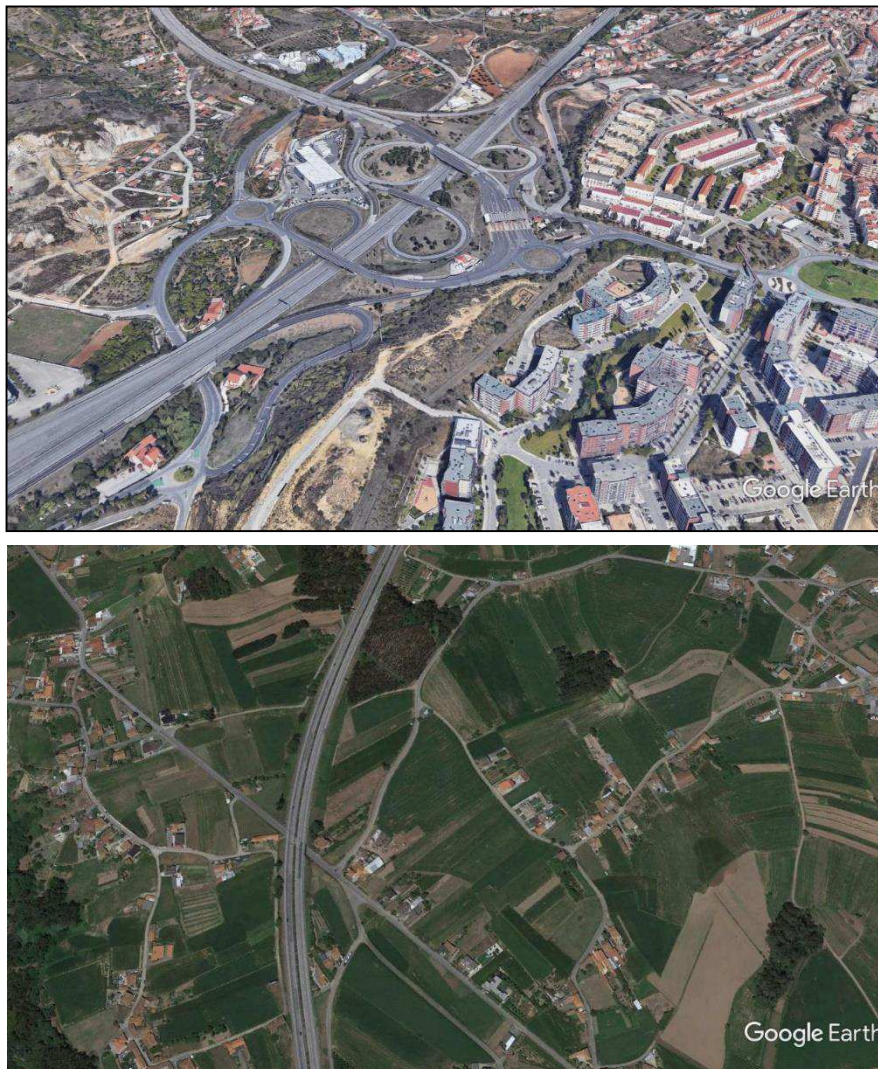
Figura 2 – Imagens aéreas da A1, na zona de Alverca (em cima) e no concelho de Estarreja (em baixo)
