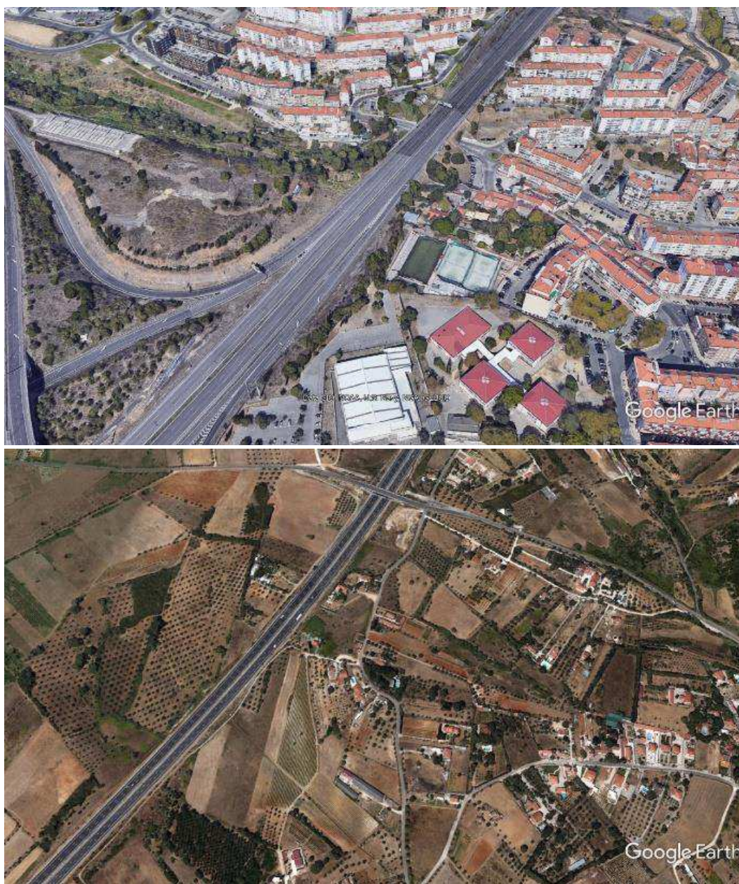
Figura 2 – Imagens aéreas da A1 na zona de Loures (em cima) e no concelho do Cartaxo (em baixo)
